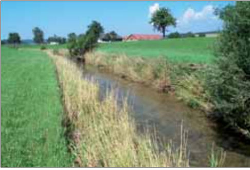
Abb. 9: Regulierter und restrukturierter Abschnitt der Mank
